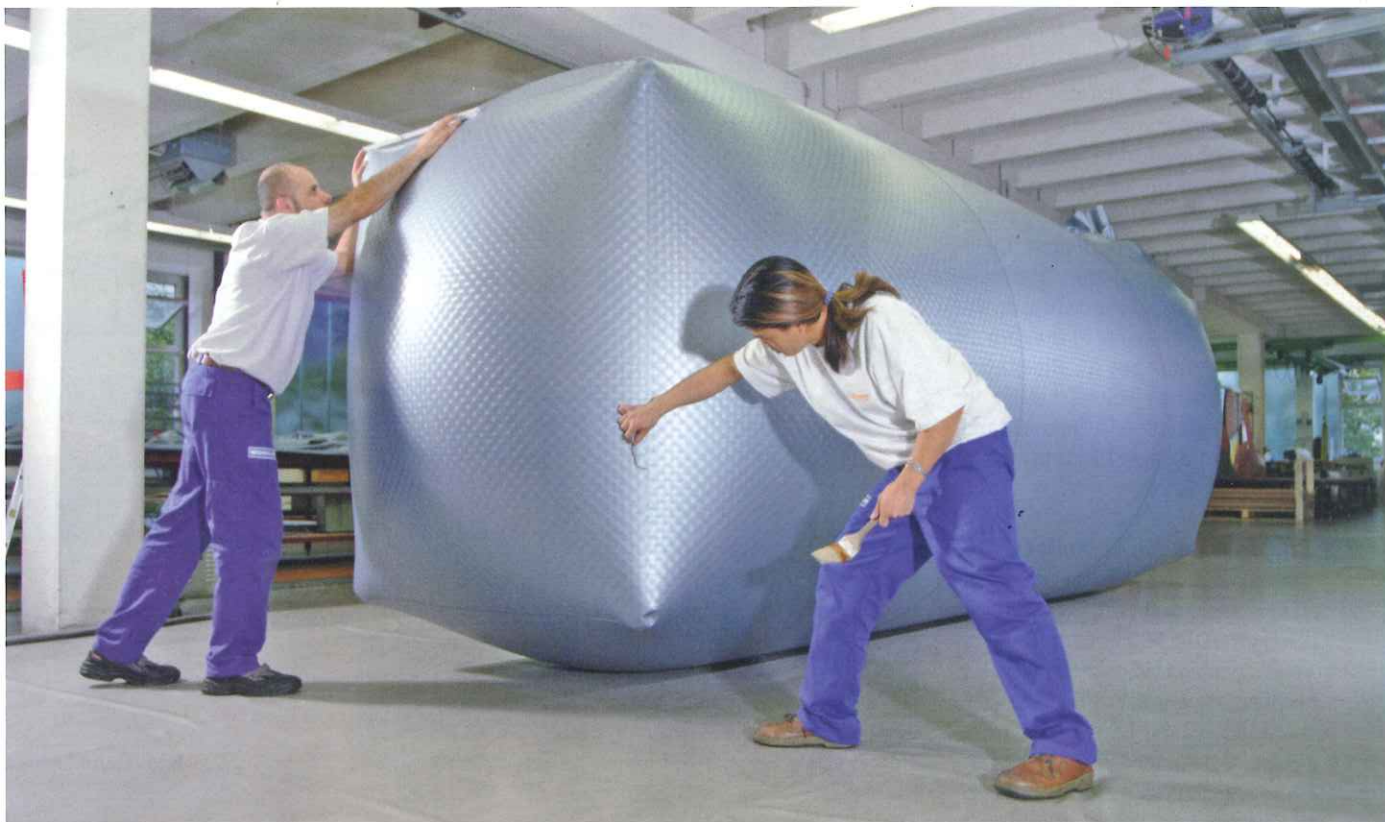
Kunststoff-Innenhülle zur Nachrüstung eines alten, aber nicht korrodierten Stahltanks.
