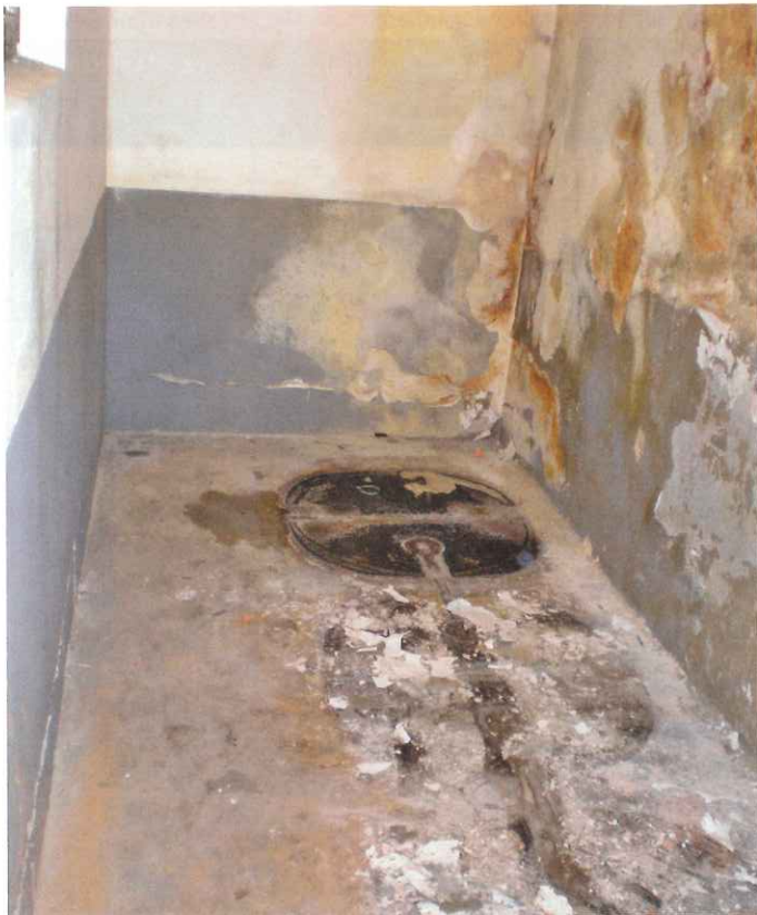
So finden Sanierer häufig alte Heizöltank-Aufstellräume vor.
