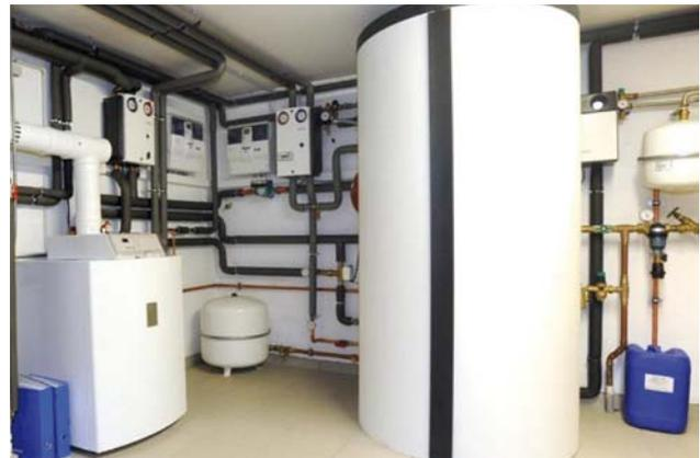
Abb. 18: Brennwertanlage mit Pufferspeicher
