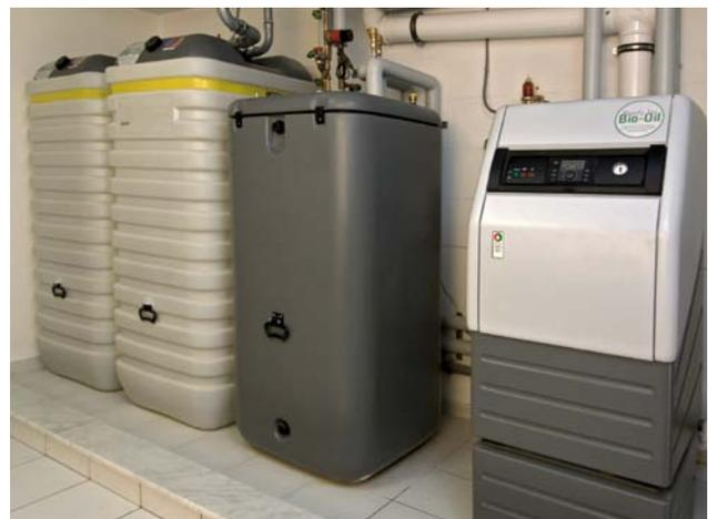
Abb. 11: Platzsparende, oberirdische Lagerung neben dem Brennwertkessel
