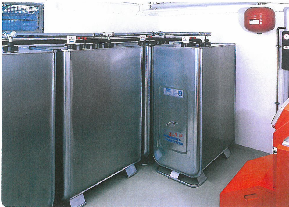
Kunststoff-Sicherheitstanks mit integrierter Auffangwanne aus verzinktem Stahlblech Foto: Dehoust
